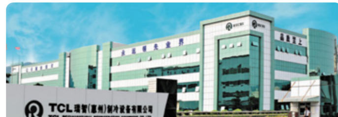
Завод "TCL - Reichi Compressor" (16 млн. компрессоров для кондиционеров)
