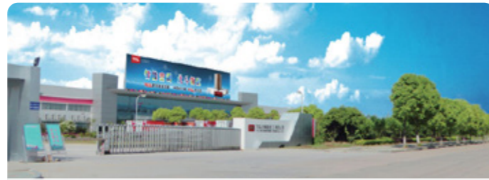
Завод в г. Ухань (5 млн. кондиционеров)
