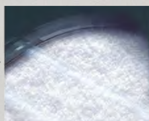
Обмерзание теплообменника
