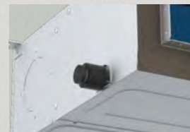
Вывод дренажа с двух сторон
