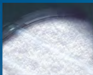
Обмерзание теплообменника
